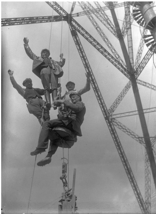
Abbildung 13: Arbeiter im Mittelturm, September 1929. BArch.
