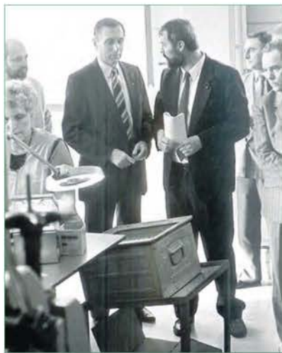
Felix Meier Minister f. Elektrotechnik-Elektronik, Günter Wagner Betriebsdirektor VEB Antennenwerke Bad Blankenburg
