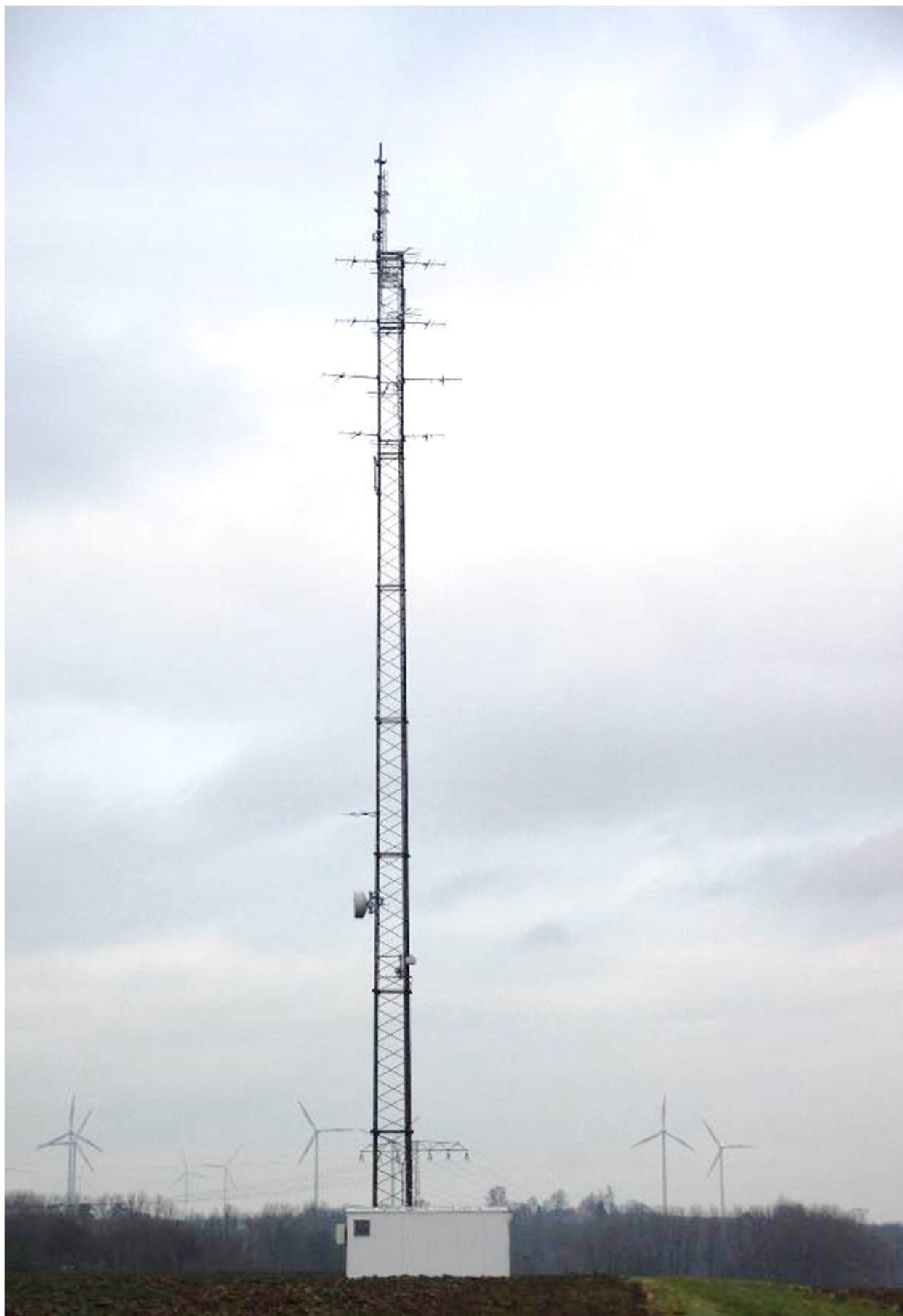
Dietmar Ullrich schickte mir ein Foto vom jetzt vorhandenen UKW Sender der Zittau und Umgebung versorgt. Dort sind 4 Programme des MDR mit Sendeleistungen zwischen 200 und 500 Watt installiert.
